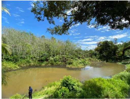
Gambar 1. Kondisi bendungan di Desa Sawang Lebar
